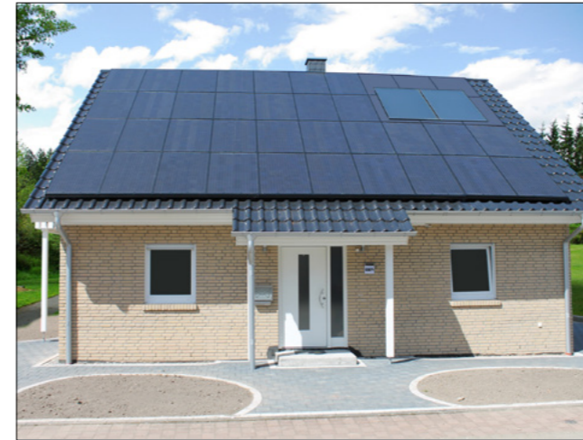
SOL-50 mit Verblendung von zwei Thermiekollektoren
