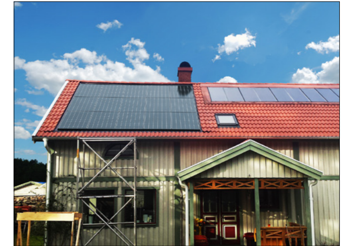
SOL-50 Indachanlage in Schweden (links)
