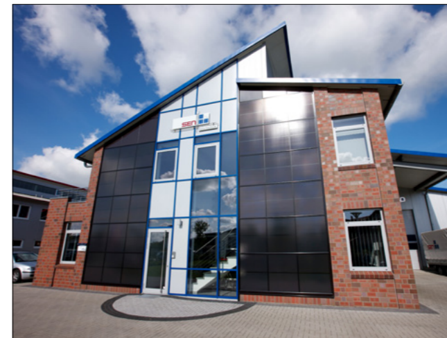
SOL-50 Fassadenanlage mit Verblendern in der Schräge
