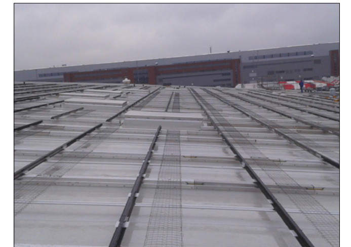
SOL-50 Direktmontage Energie-, Bildungs-, Erlebniszentrum Aurich (EEZ)
