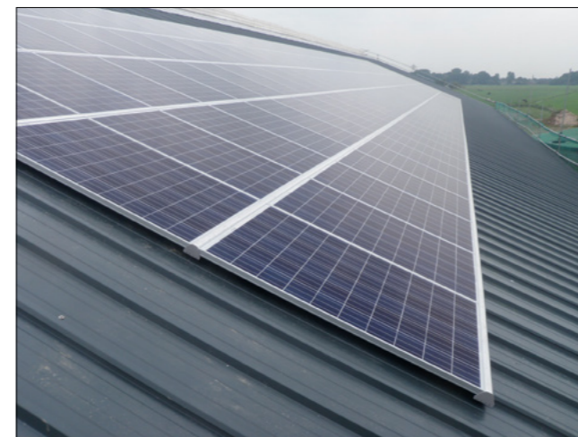
SOL-50 Trapezprofildach, Direktmontage
