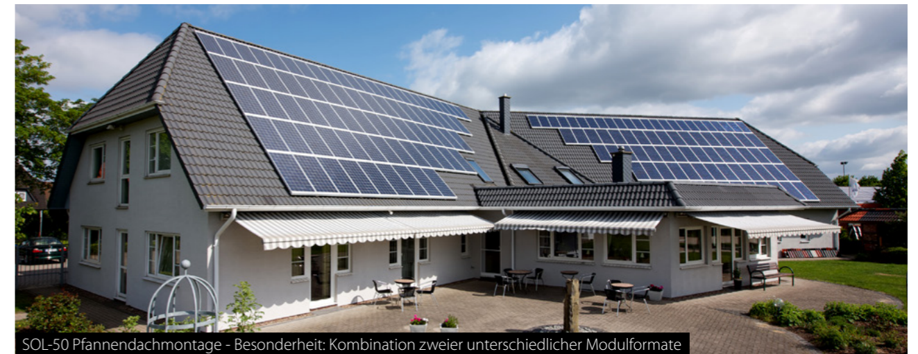
SOL-50 Pfannendachmontage - Besonderheit: Kombination zweier unterschiedlicher Modulformate
